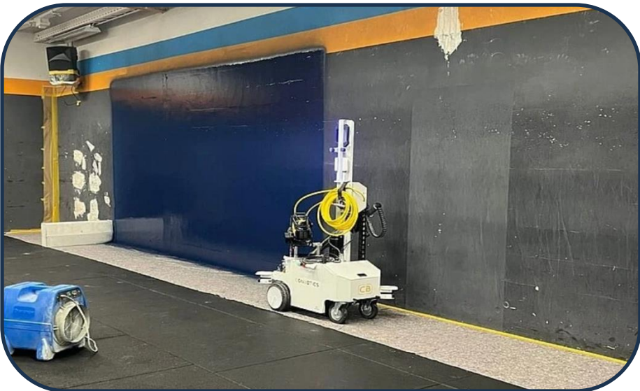
Malerroboter im Einsatz
